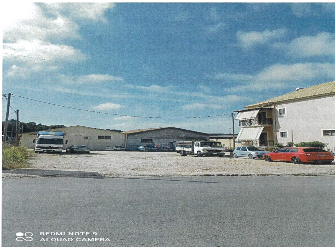
ΦΩΤΟ ΥΦΙΣΤΑΜΕΝΗΣ ΚΑΤΑΣΤΑΣΗΣ
